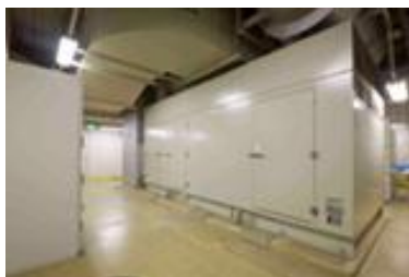
停電等の非常時に備え非常用自家発電設備・UPSを設置
