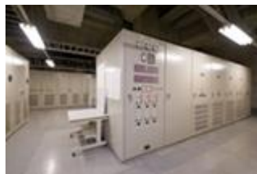
停電等の非常時に備え非常用自家発電設備・UPSを設置
