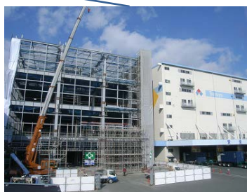
鉄骨工事完了
