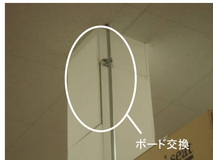
【柱耐火ボード破損】
