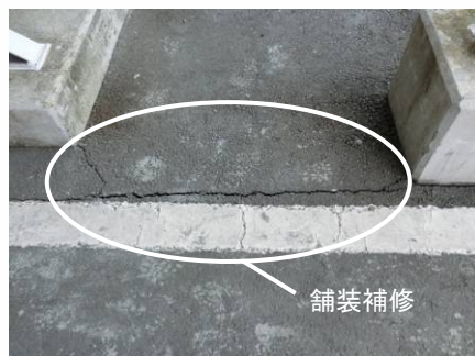
【アスファルト舗装ひび割れ】
