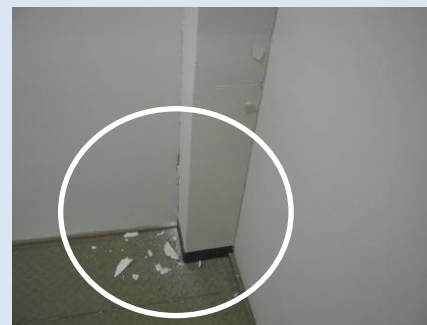
階段室化粧柱型脱落
