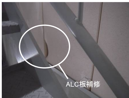
【屋内非常階段間仕切り板破損】
