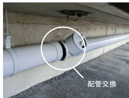
【雨水配管破損】
