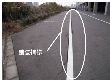
【アスファルト舗装ひび割れ】
