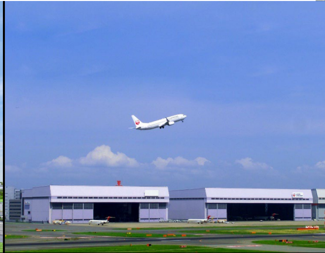
IIF羽田空港メンテナンスセンター（東京都）
