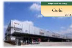
IIF野田ロジスティクスセンター
