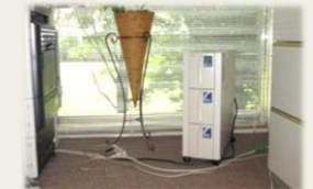
IIF東雲R&Dセンターのポータブル型蓄電池
