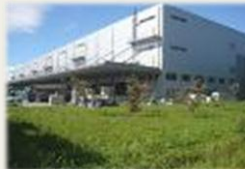
IIF野田ロジスティクスセンターにおける緑化
