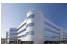
I-4 IIF品川データセンター
