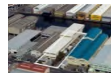
F-10 IIF浦安 マシナリーメンテナンス センター (底地)
