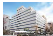
I-5 IIF大阪豊中 データセンター
