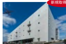
L-35 IIF福岡箱崎 ロジスティクスセンターⅡ
