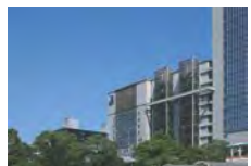
I-1 IIF神戸地域 冷暖房センター
